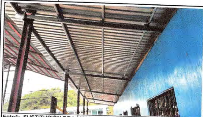
Foto 1: SUSTITUCIÓN DE LÁMINAS Y ESTRUCTURAS METÁLICAS POR DETERIORO
