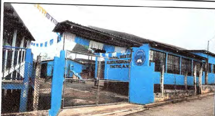
Foto 3: SUSTITUCIÓN DE PORTÓN Y ENTECHADO POR DETERIORO.
