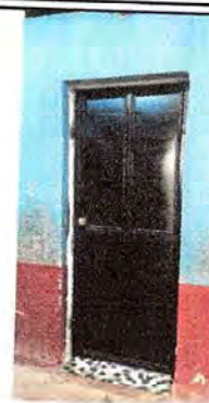
Foto 2: SUSTITUCIÓN DE PUERTA DE MADERA POR METAL POR DETERIORO.
