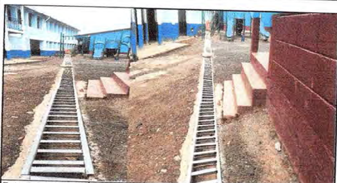
Foto 5: SUSTITUCIÓN DE REJILLAS EN CUNETAS POR DETERIORO EN ENTRADA AL ESTABLECIMIENTO.
